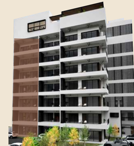
Ubicación en el edificio - Fachada lateral 2
