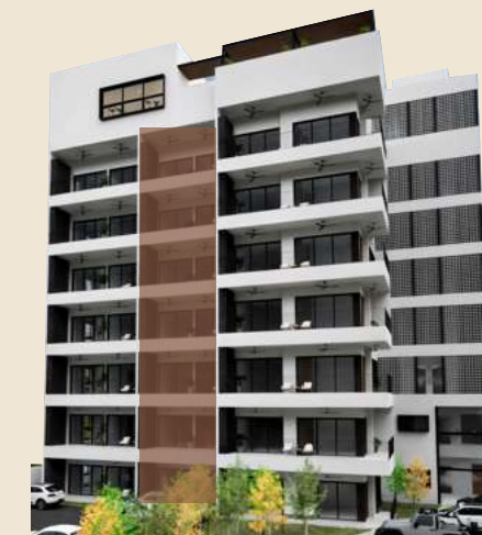
Ubicación en el edificio - Fachada lateral 2
